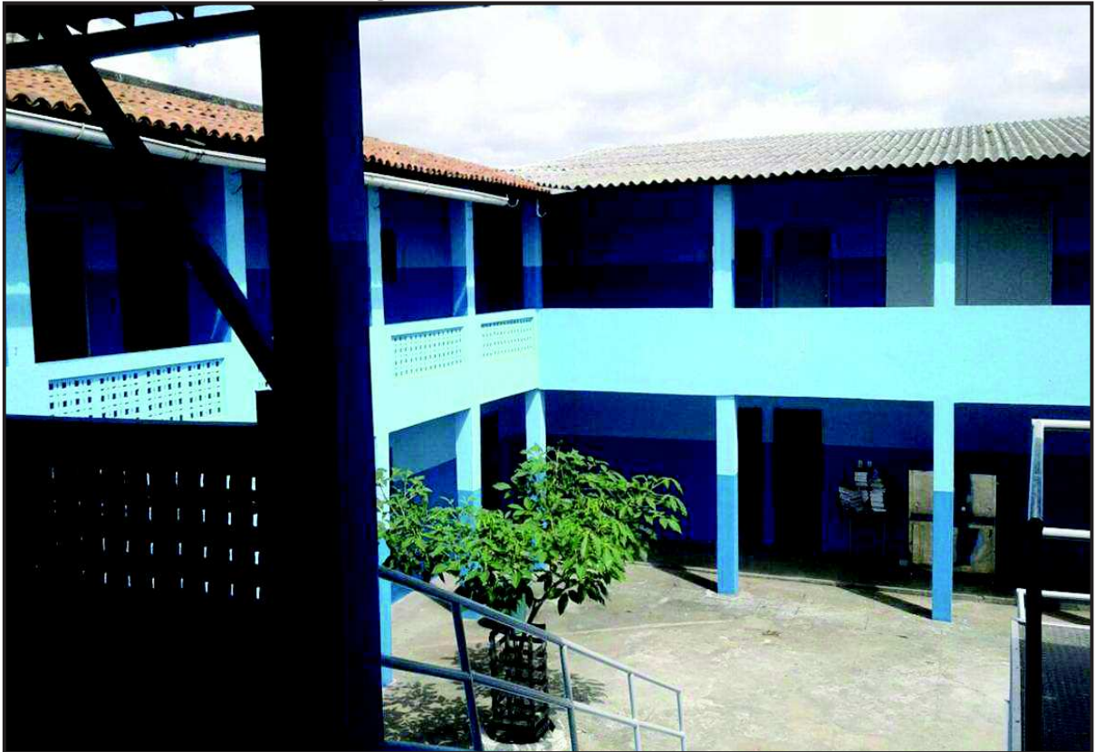
Figura 1: Estrutura interna da escola
