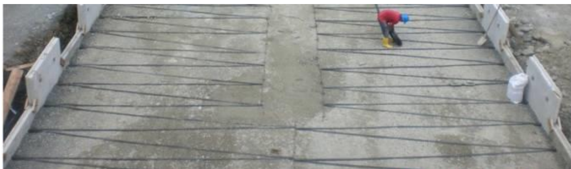
Figura 8- Execução de Terra armada
