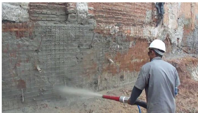
Figura 5- Execução de solo grampeado
