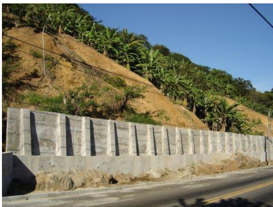
Figura 4- Muro de arrimo de flexão com contrafortes
