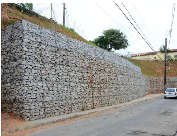
Figura 2- Muro de Arrimo de gravidade tipo gabião
