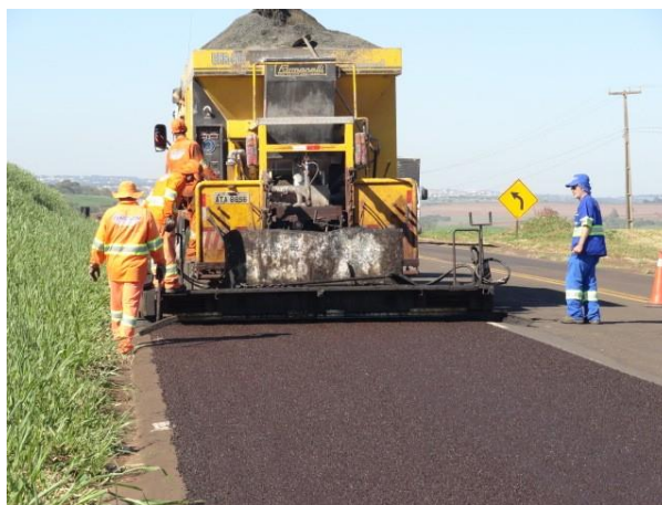
Figura 4 - Execução de Pavimentação asfáltica em microrrevestimento. (Fonte: www.fircon.com.br )
