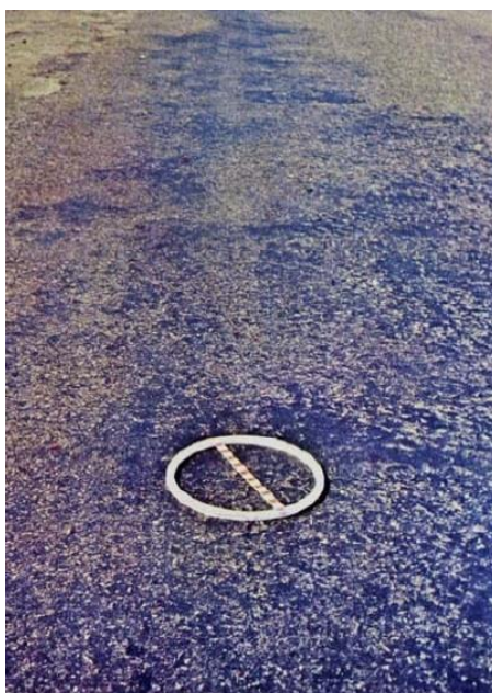
Figura 16 - Detalhe da Exsudação (EX) (Fonte: DNIT 005/2003-TER)
