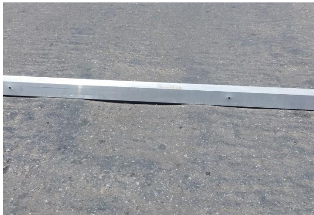
Figura 26 – Afundamento (A)
