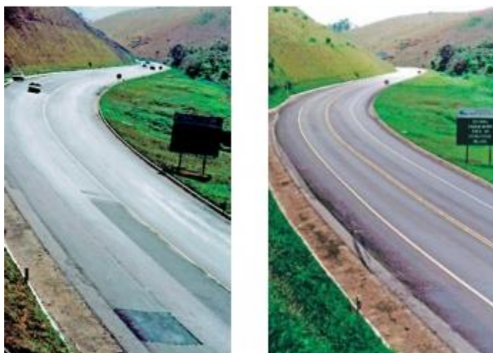
Figura 3 - Exemplo de aplicação de microrrevestimento (Fonte: Bernucci, 2010)
