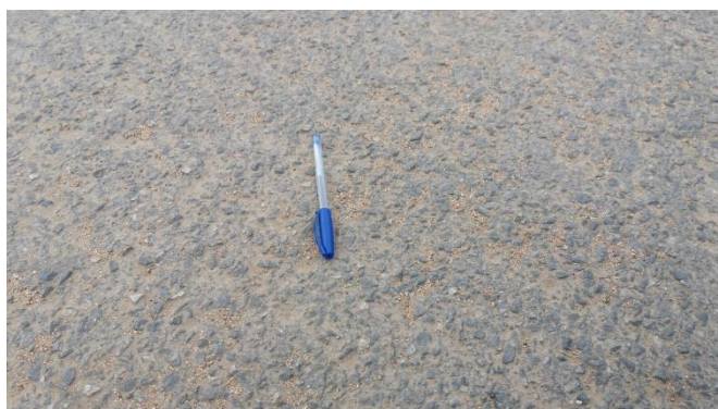
Figura 33 - Desgaste (D)
