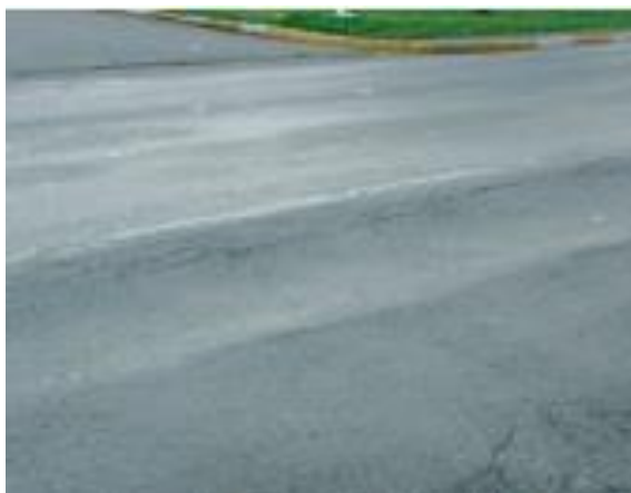
Figura 13 - Afundamento plástico nas trilhas de rodas- ATP (Fonte: Bernucci, 2010)
