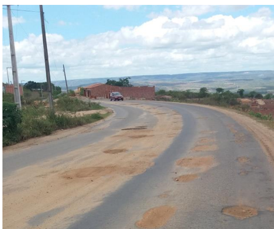
Figura 28 - Conjunto de Painelas (P)
