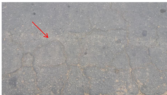
Figura 24 - Trinca tipo couro de Jacaré (J)
