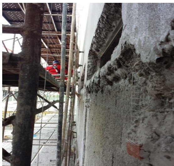
Figura 6: Tela eletrosoldada entre as cheias de emboço
