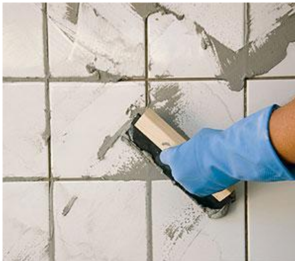
Figura 16: Aplicação de rejunte com desempenadeira de borracha
