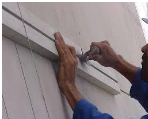
Figura 8: Corte da junta de movimentação com frisador
