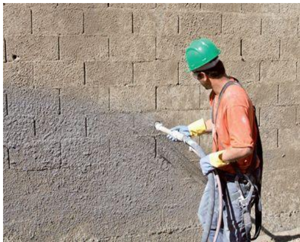
Figura 12: Aplicação de chapisco projetado
