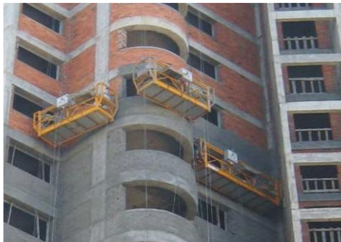
Figura 1: Balancins em movimento com pedreiros aplicando chapisco
