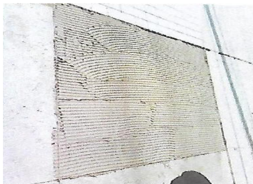
Figura 14: Argamassa colante espalhada em área suficiente para aplicação fresca
