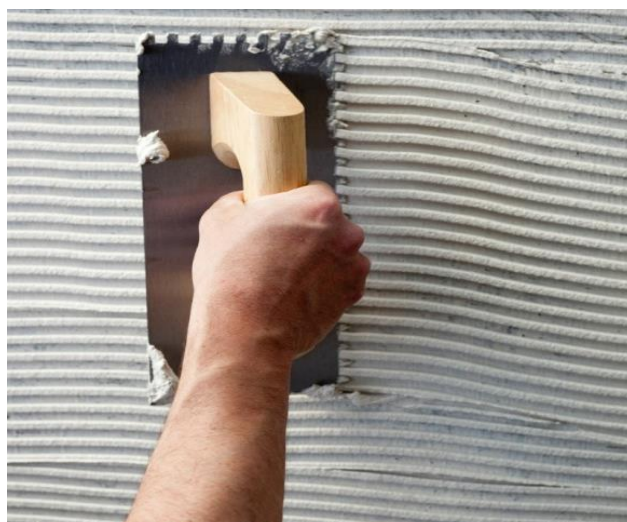
Figura 13: Aplicação de argamassa colante AC III com cordões na horizontal
