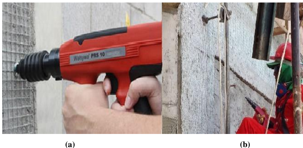
Figura 5: Colocação de tela metálica para reforço de emboço
