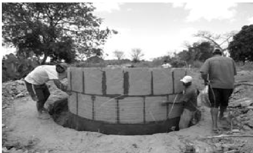
Figura 2. Construção de cisterna de Placas. Fonte: ASA, 2014.
