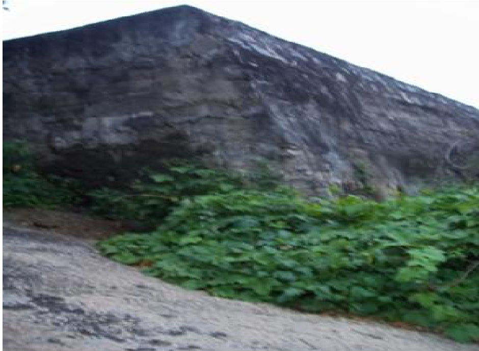
Figura 11. Vista do Tanque de Pedra (angulo externa com a presença de alvenaria). Sitio Sítio Olho D' Água, Pocinhos, PB
