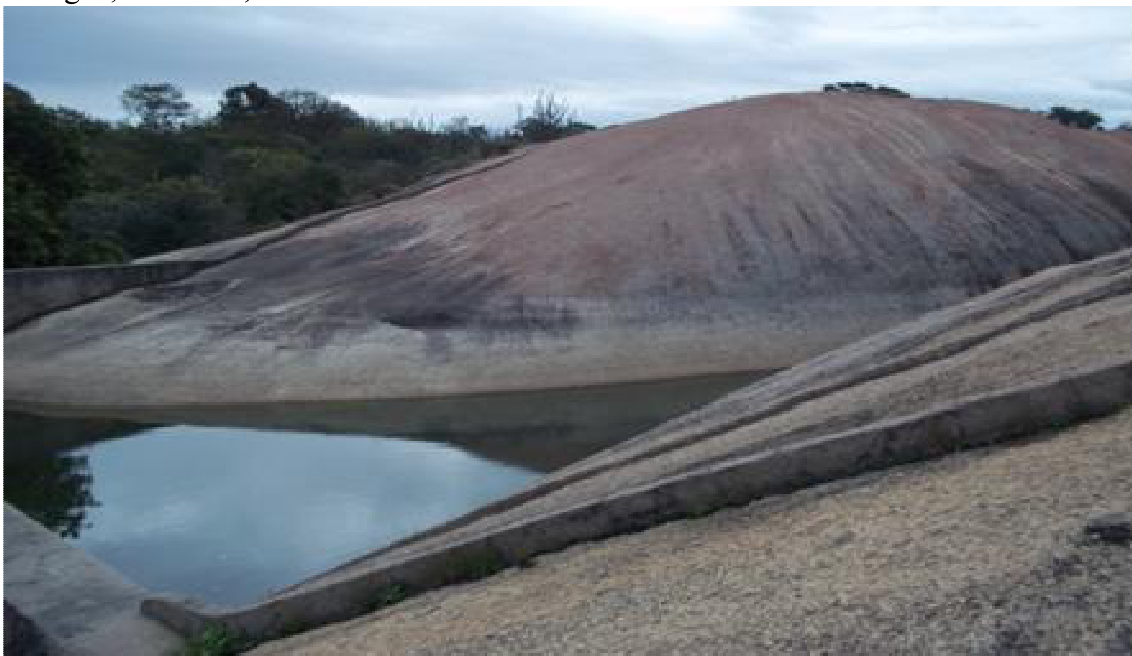
Figura 12. Vista do Tanque de Pedra (angulo interno com a presença de alvenaria). Sitio Olho D' Água, Pocinhos, PB.
