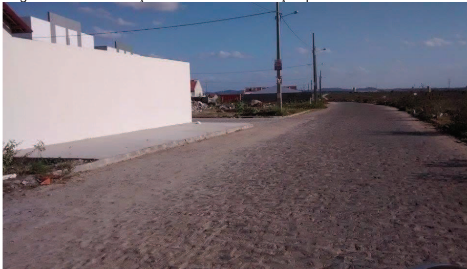
Figura 6 – Pavimentação das Ruas e iluminação pública
