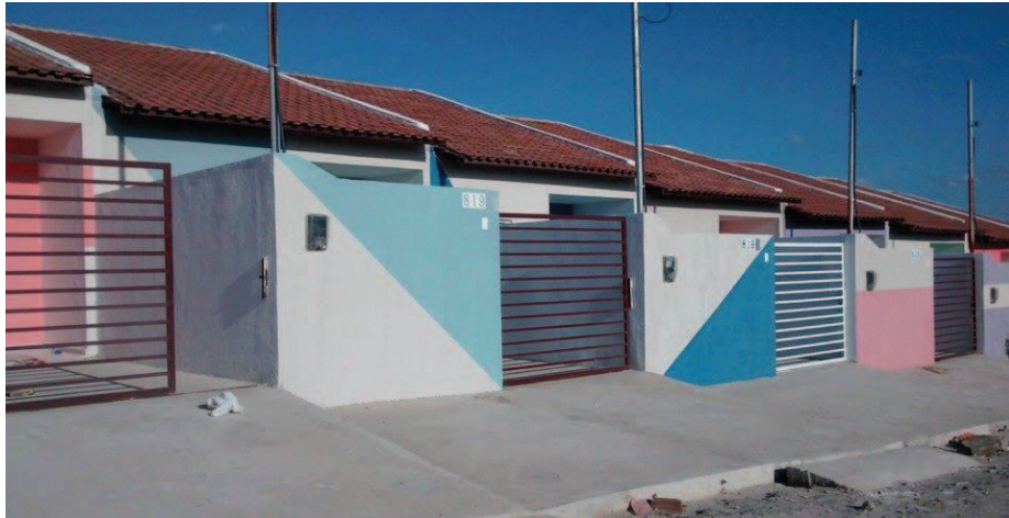
Figura 7 – Residências com energia elétrica
