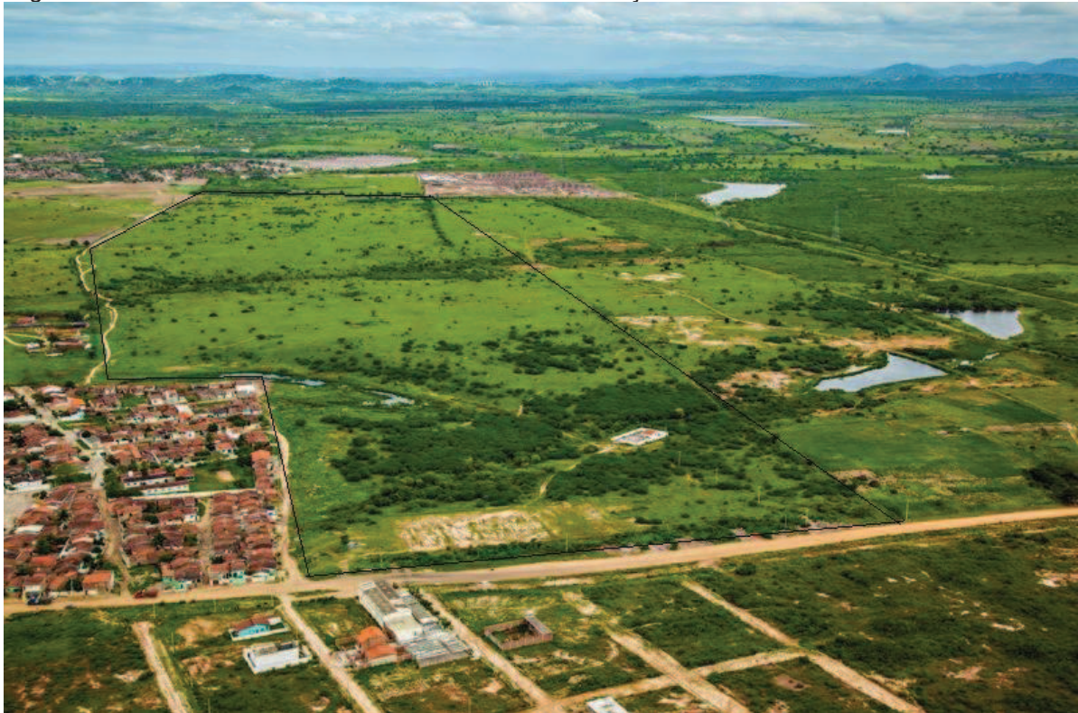
Figura 3 – Loteamento Portal Sudoeste - antes da construção do loteamento
