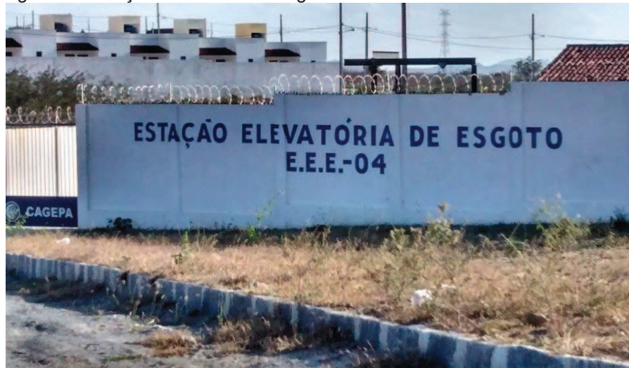
Figura 5 - Estação Elevatória de Esgoto
