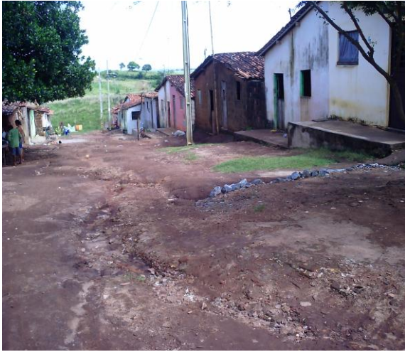
Figura 12: Habitações precárias e rua sem pavimentação. Foto: AUTORA, 2012
