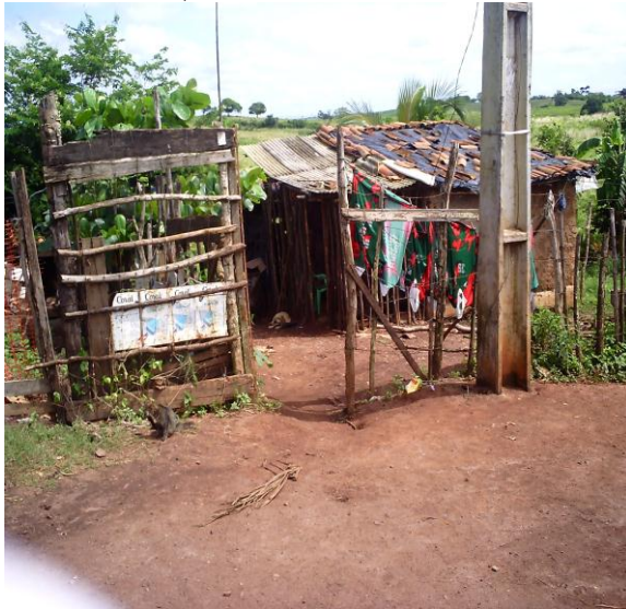
Figura 14: Casa coberta com lona. Foto: AUTORA, 2012
