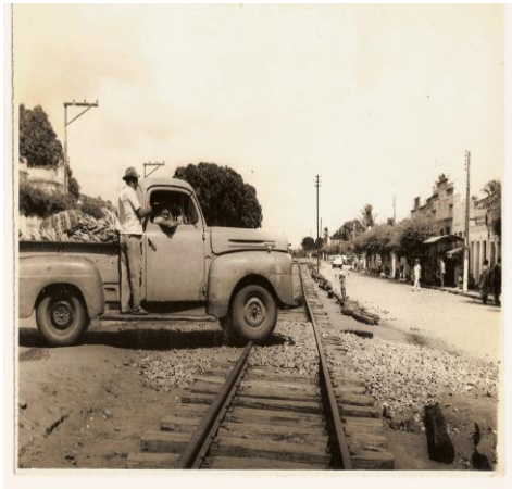
Foto 04: Principal Avenida e Linha Férrea de Sapé-PB. Foto: ROCK, 2007.
