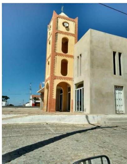
(Restauração da torre da igreja de São Francisco) Acervo da autora
