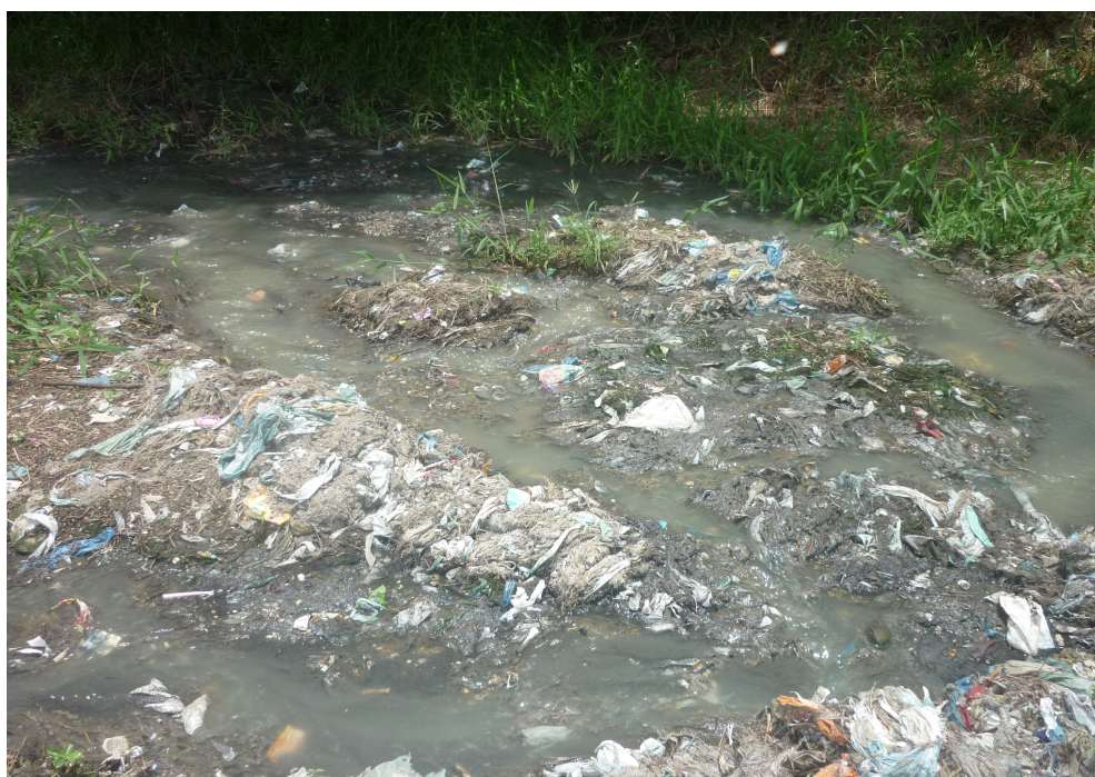
Figura 2 – Vazamento de esgoto em um dos pontos críticos. Fonte: FERNANDES (2011)
