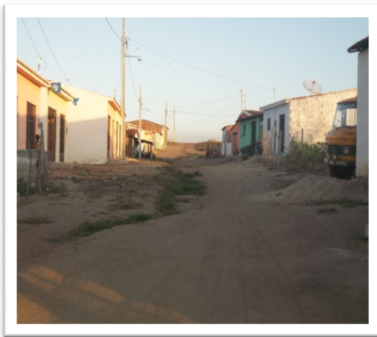
Fonte: SANTOS, Macilonia Silva / 2012. Figura 8 – Falta de infraestrutura e saneamento básico na rua “projetada”.
