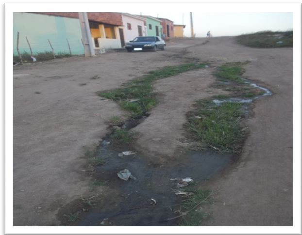
Fonte: SANTOS, Macilonia Silva / 2012 Figura 9 – Inexistência de infraestrutura e saneamento básico na rua “projetada”.
