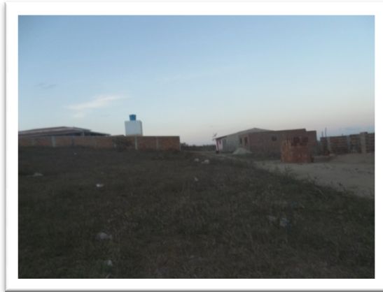
Fonte: SANTOS, Macilonia Silva / 2012. Figura 10 – Degradação ambiental em função do crescimento desordenado no loteamento Bairro Novo.
