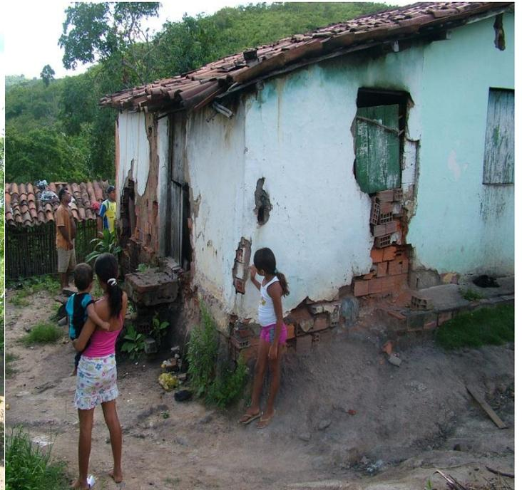
**Fotos 16 e 17: Casas de alvenaria com a estrutura comprometida.**
