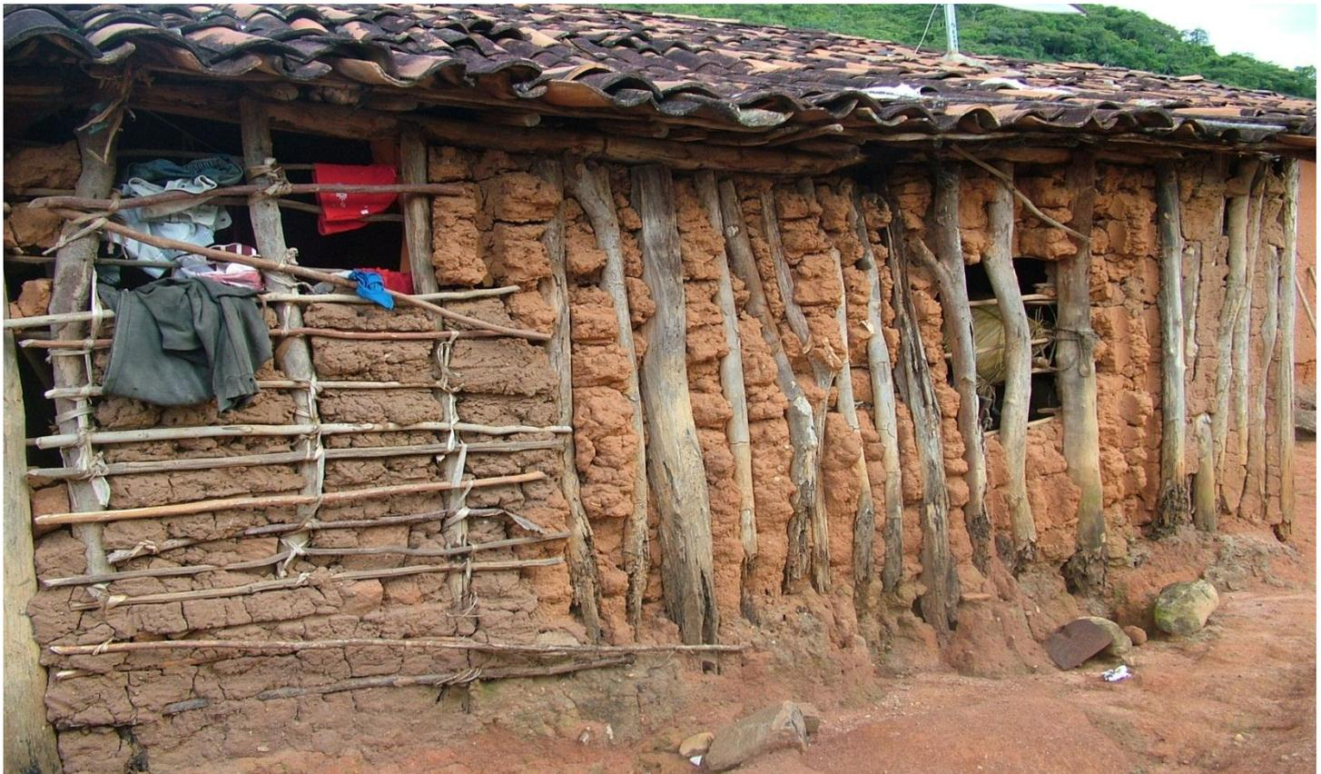
**Foto 14: Casa de taipa com parede externa não revestida, apresentando estrutura precária.**
