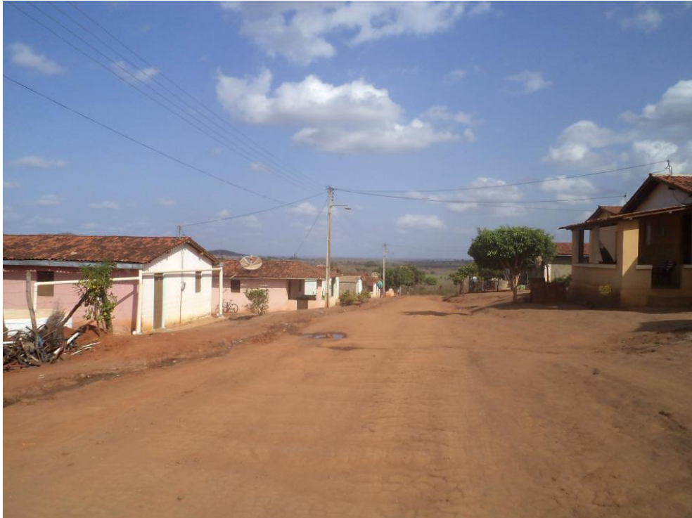
Fotografia 5 - Foto horizontal do Assentamento Senhor do Bonfim. Nessa rua foi construída uma das primeiras biroschas onde aos fins de semana os moradores do assentamento usam como lazer.
