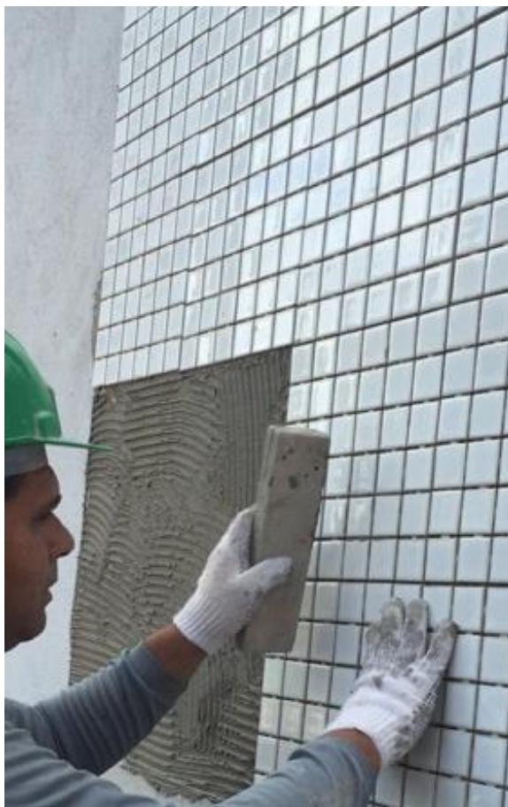
Figura 21: Assentamento de cerâmica
