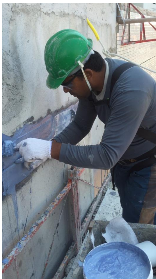
Figura 20: Tratamento das juntas
