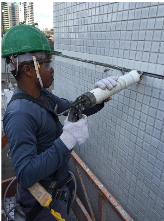
Figura 23: Aplicação do selante
