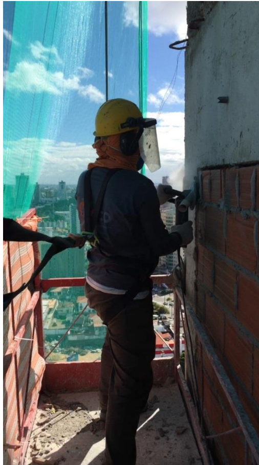
Figura 8: Limpeza seca
