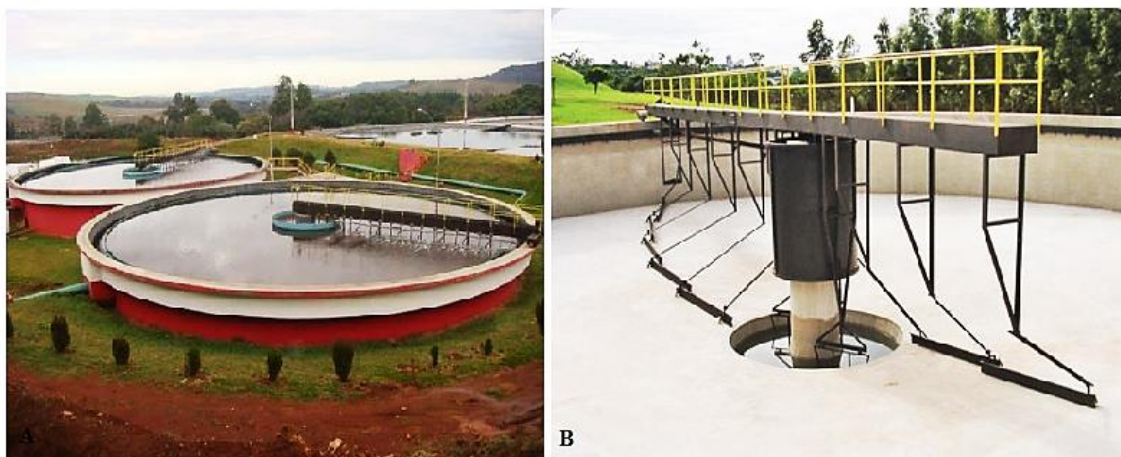
Figura 5. A-B: Sedimentador periférico com braço raspador (Fonte: http://www.vironquip.com.br/ ).
