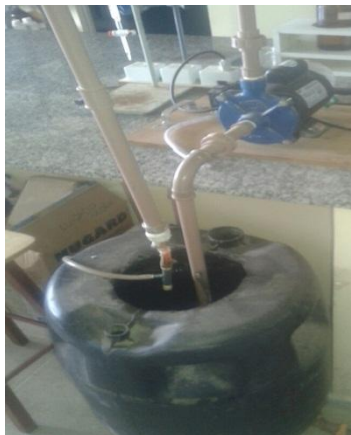
Figura 15 - Equipamentos Elétricos – Bomba d'água, no LAPECA
