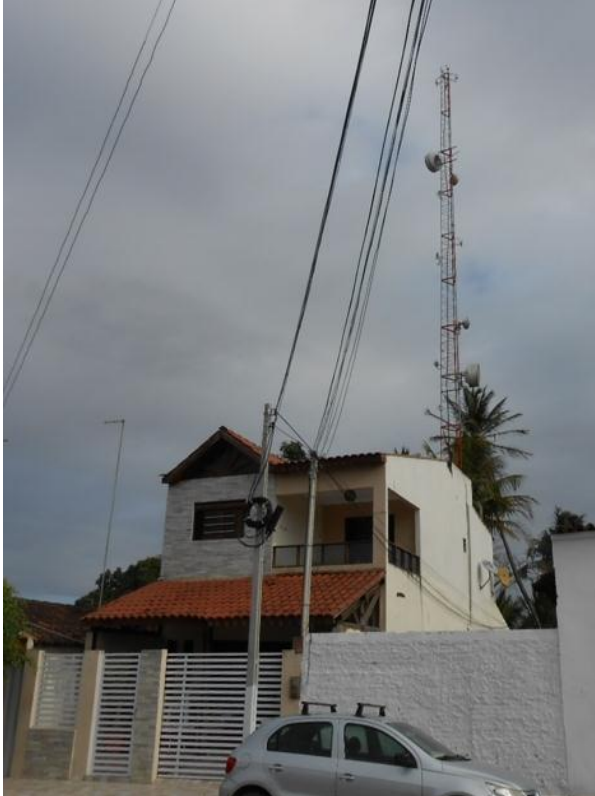
Figura 5: antena emissora de rede.
