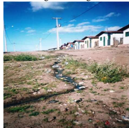
Figura 13- Esgoto a céu aberto – Conj. Humberto P. Madrugá – Mulungu - PB
