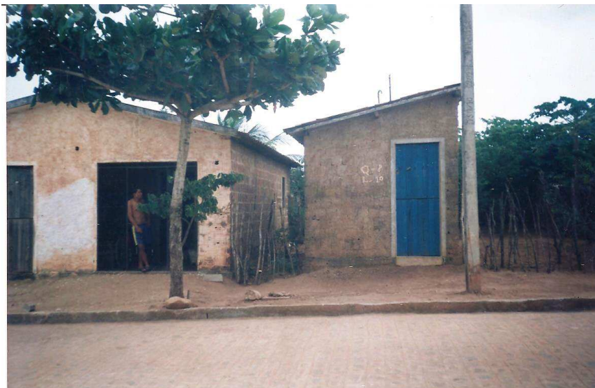
Figura 4- Casa do tamanho original – Conjunto Achilles Leal – Mulungu - PB
