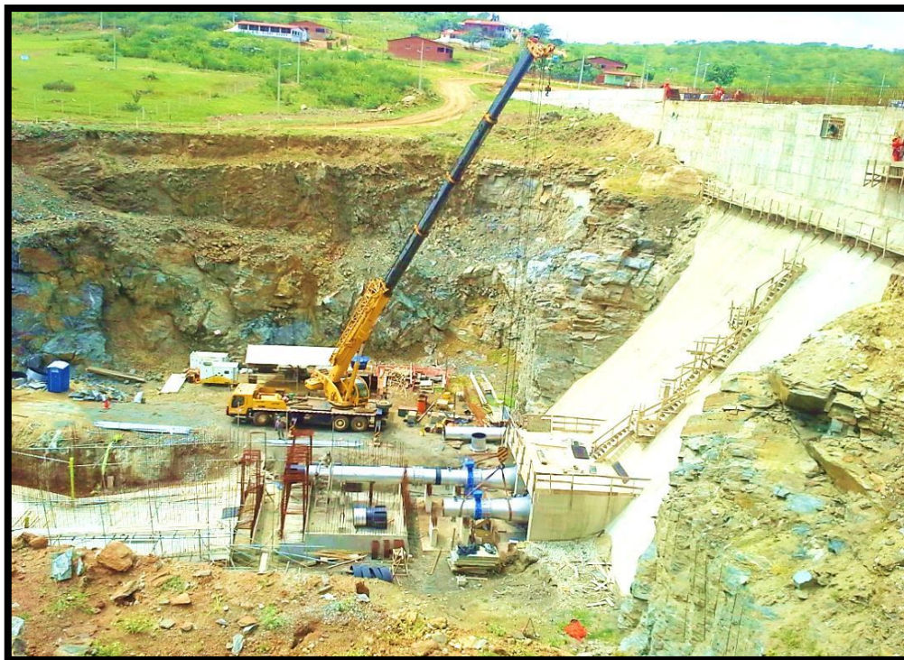
Figura 6: Maquinas ativas na obra do Consórcio Acauã, município de Itatuba/PB
