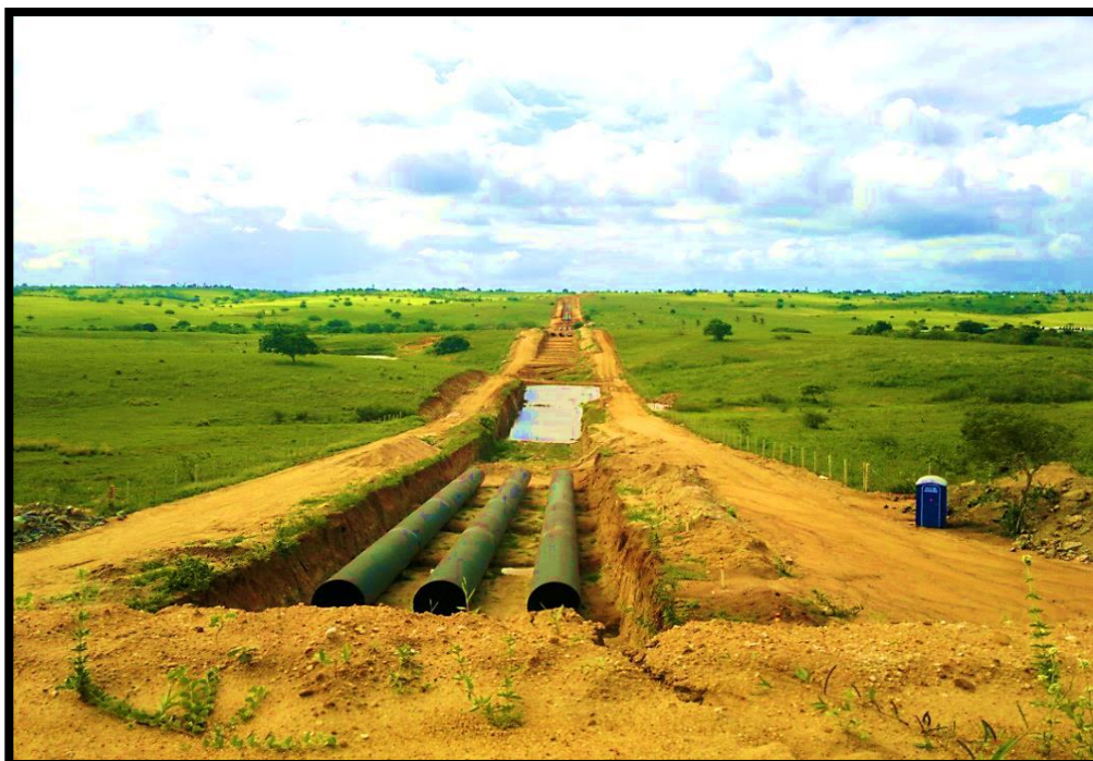
Figura 5: Instalação de tubulações do Sifão na comunidade do Curimataú
