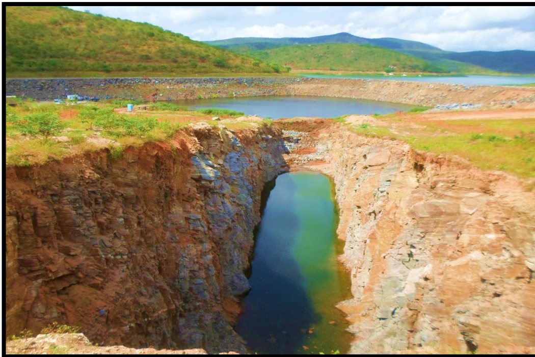
Figura 8: Ensecadeira, canal de aproximação e Tomada d'água, Barragem de Acauã, Itatuba/PB
