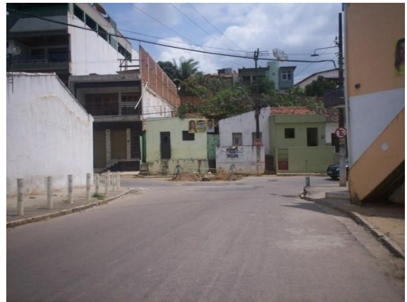
Figura 6: Entrada da Rua Manoel de Freitas Pessoa, com acesso a Rua São Manoel, Guarabira/PB Fonte: Acervo da autora, 2014.
