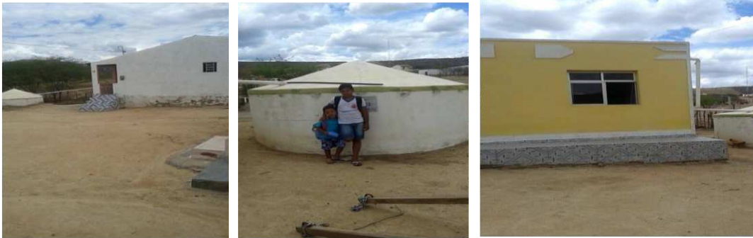
Figuras 3, 4 e 5. Residências com cisternas de placa pertencentes ao P1MC, com suas instalações.
