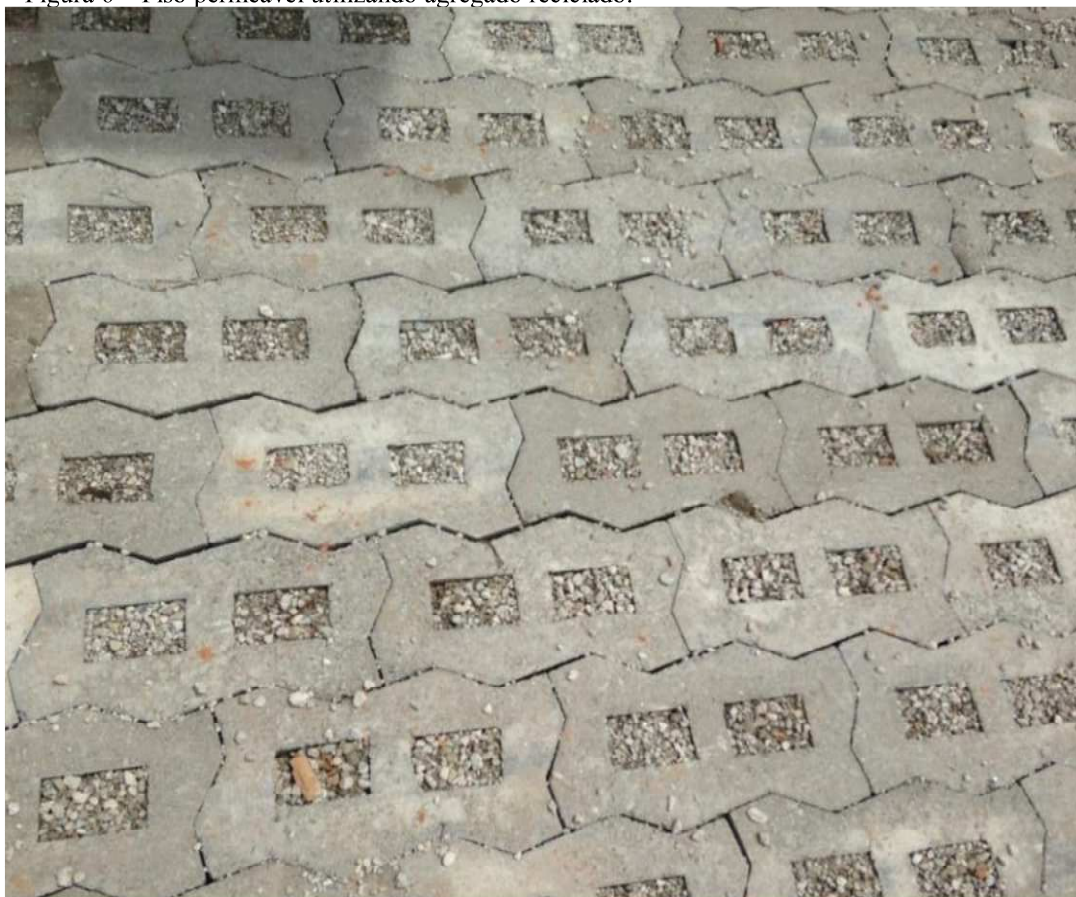
Figura 6 – Piso permeável utilizando agregado reciclado.
