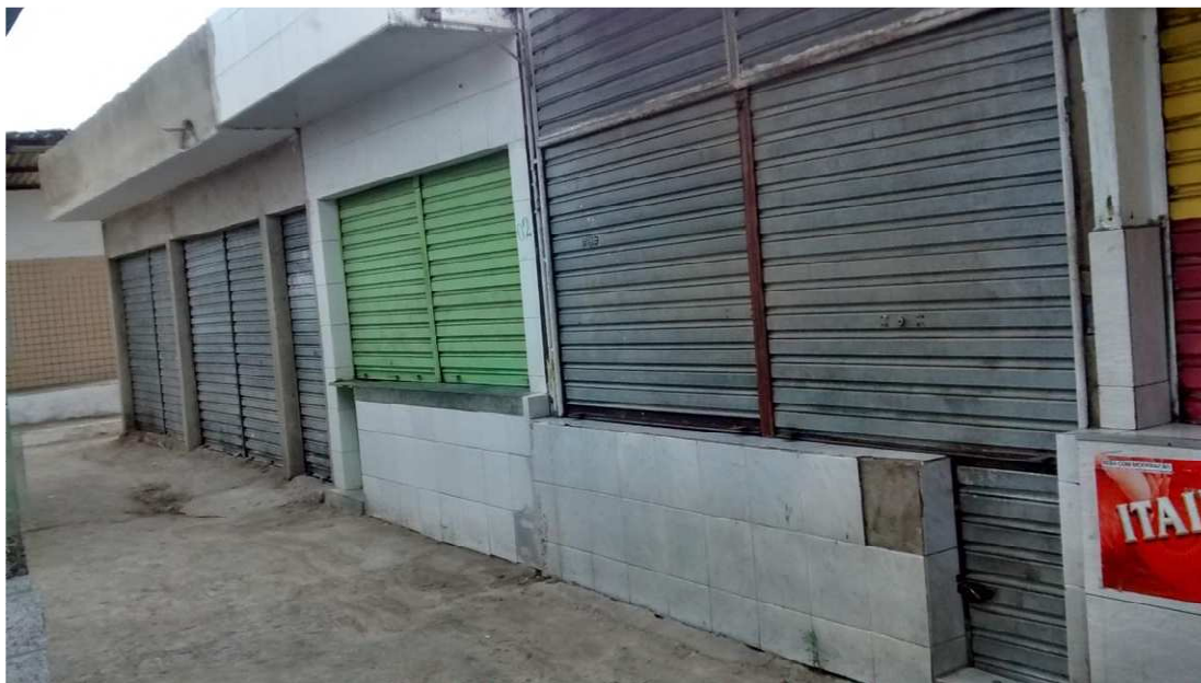
Figura 18 - Espaço atual da feira livre construção de boxes de alvenaria
