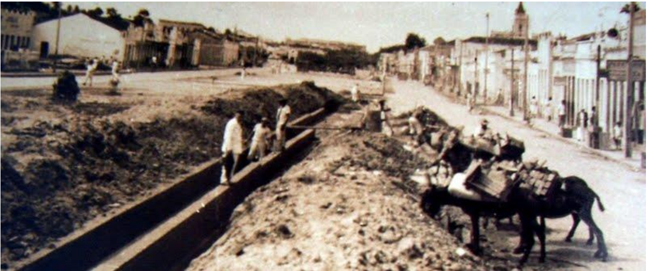
Figura 02: Centro histórico de Guarabira com suas primeiras galerias pluviais em trechos da antiga lagoa, em 1938 e que hoje é a atual Praça Lima e Moura.
