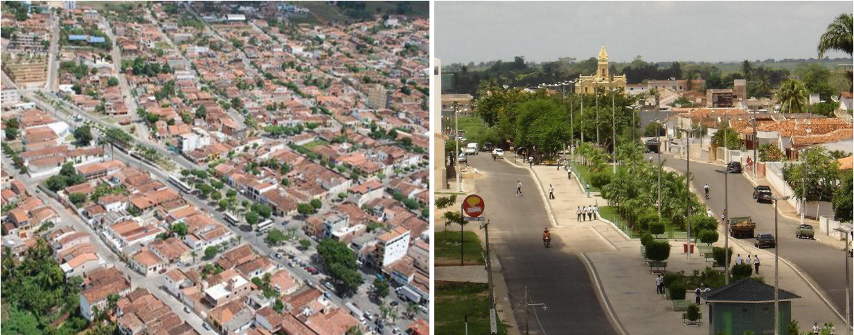
Figura 07 – Vista panorâmica do Bairro Novo. Guarabira-PB
