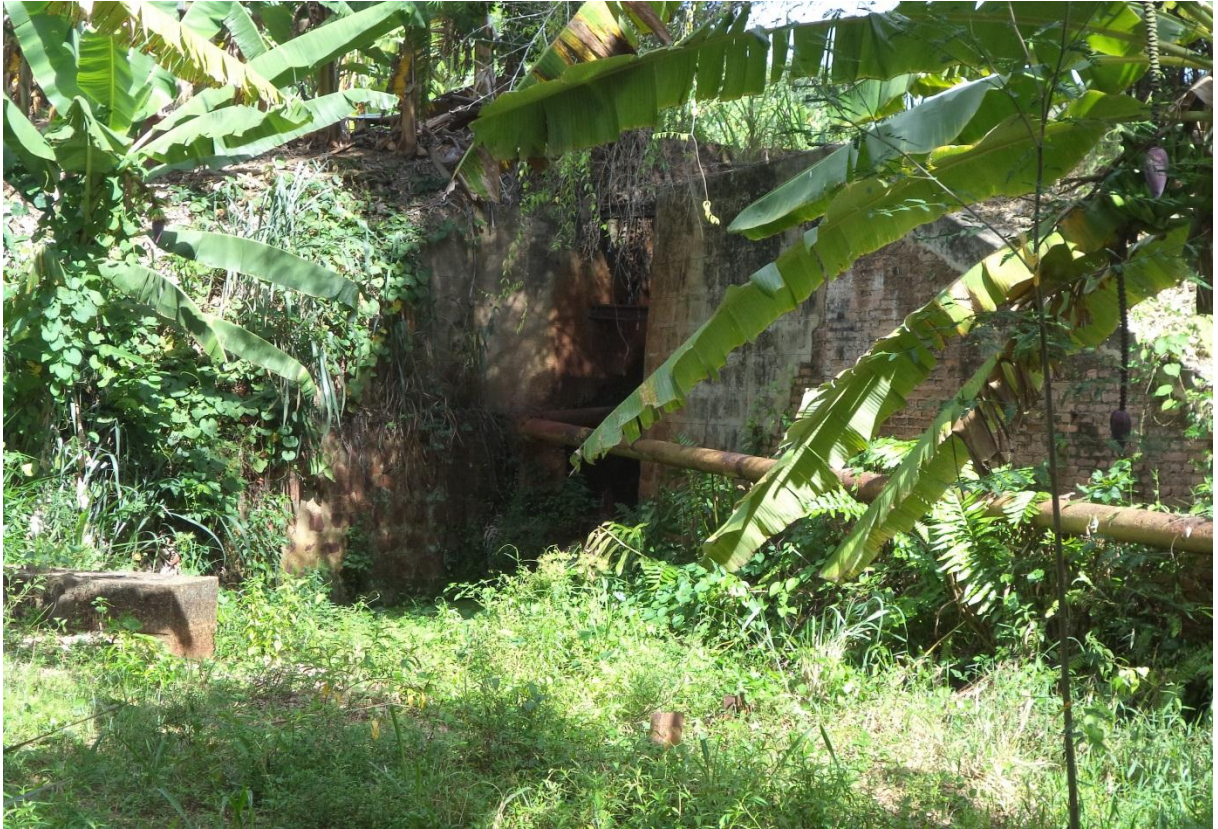
Imagem 5. Tubulações da Usina Santa Maria, ainda utilizados para a irrigação de banana.
