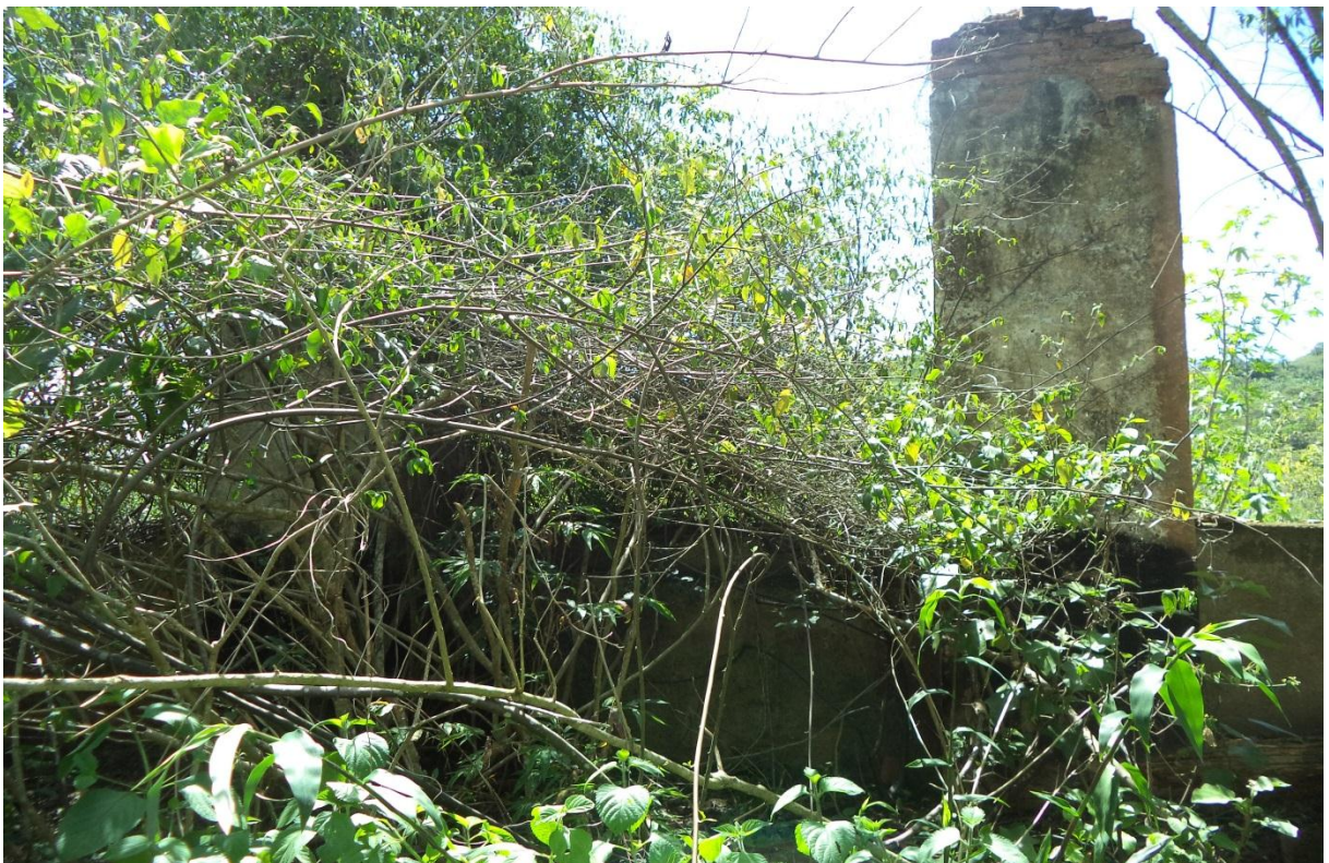
Imagem 4. Ruínas do Engenho Cantinhos.
