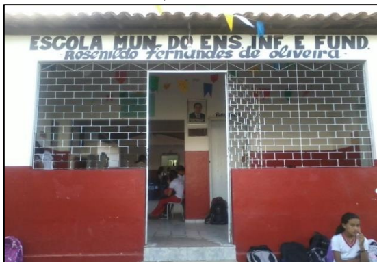
Figura 4 – Entrada Principal da EMEIF Rosenildo Fernandes de Oliveira, Jacaraú-PB.
