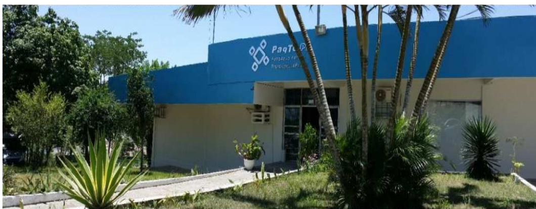
Figura 1: Vista parcial da fachada da Fundação PaqTcPB, localizada no bairro Bodocongó, em Campina Grande/PB
