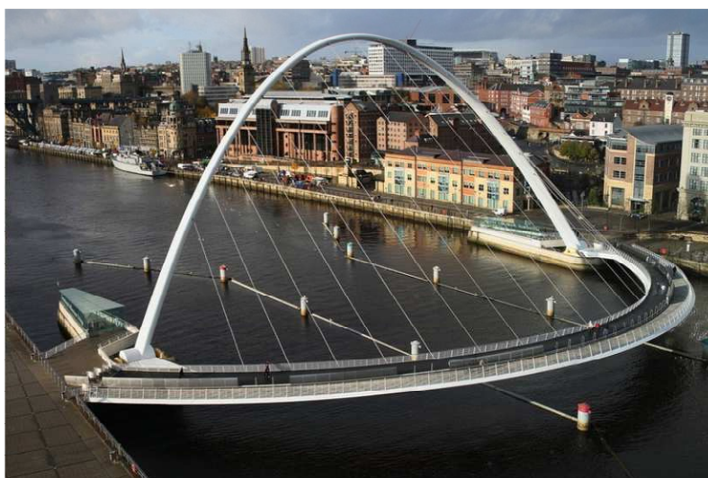
Figura 25 – Gateshead Millennium Bridge, Inglaterra. Fonte: Enciclopédia Culturama.
