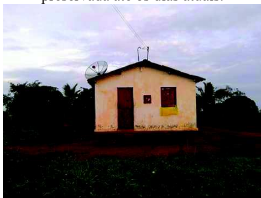
Figura Nº 6 - Primeira casa de tijolos e cimento construída na antiga fazenda Reunida Recreio, preservada até os dias atuais.
