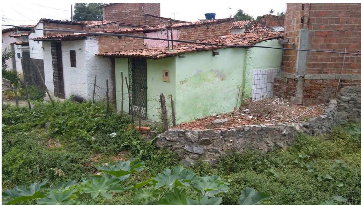
Figura 3: Residências ocupando a planície de inundação do Riacho das Piabas
