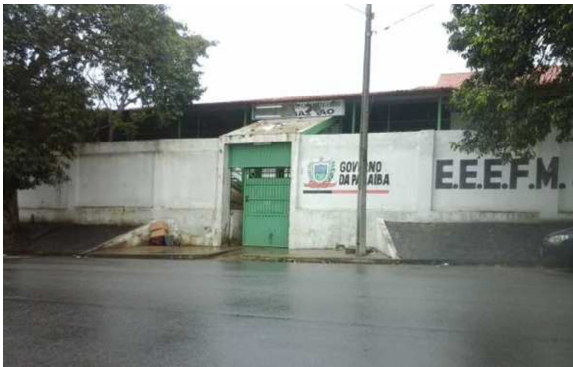
Figura 2: Fachada da Escola São Sebastião
