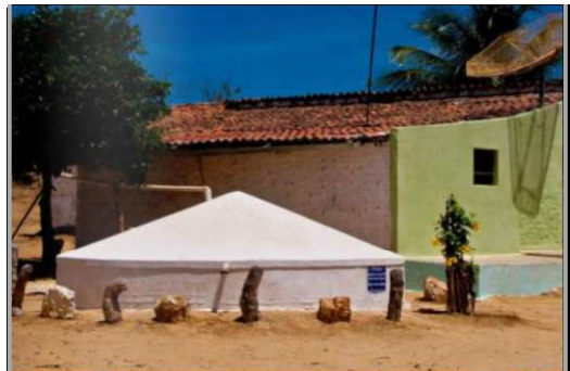
Figura 7. Cisterna de placa de cimento, usada no P1MC. Fonte: ASA, (2016)
