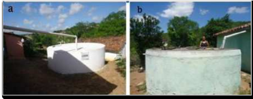
Figura 24. (a) Cisterna construída pelo P1MC; (b) Cisterna construída pelos moradores sem o sistema desvio das primeiras águas de chuva.
