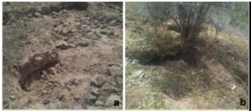
Figura 27. (a) Solo erodido pela retirada do barro; (b) Raízes de árvore expostas.
