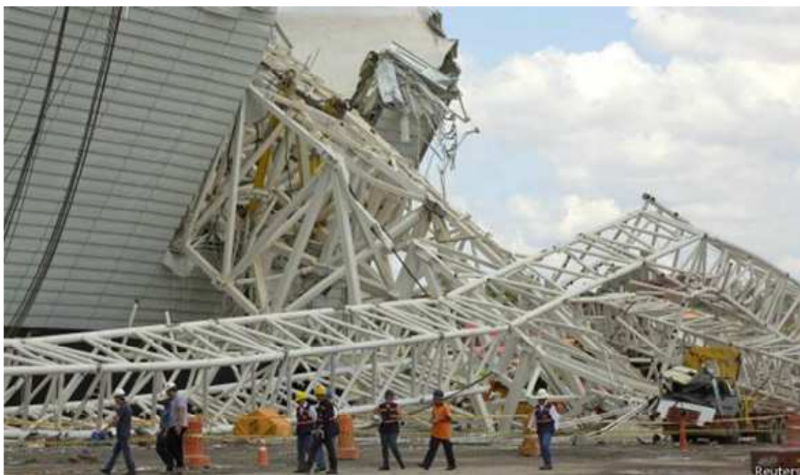
Figura 03: Queda de um guindaste na Arena Corinthians
