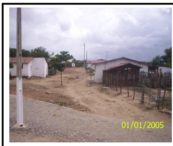
FOTO 2: Comunidade de Quixaba, Riachão/PB. Rua Projetada antes da pavimentação.
