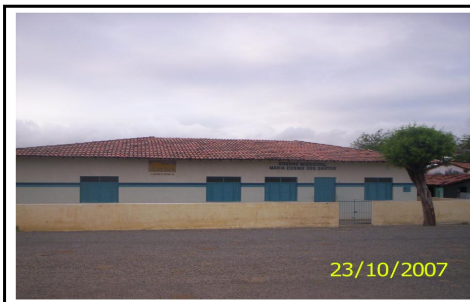
FOTO 7: Comunidade de Quixaba – Riachão/PB. Creche Municipal Maria Cosmos dos Santos. FOTO: José Cunha Lima
