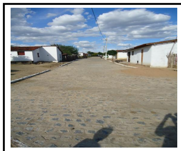
FOTO 3: Comunidade de Quixaba, Riachão/PB. Rua Projetada depois da pavimentação.
