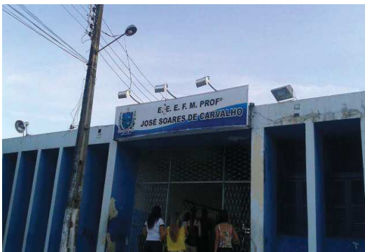
Vista externa da escola
