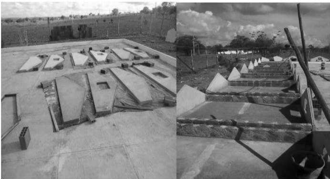
Figura 5: Dessalinizadores em construção sobre o calçadão utilizando-se blocos pré-moldados.
