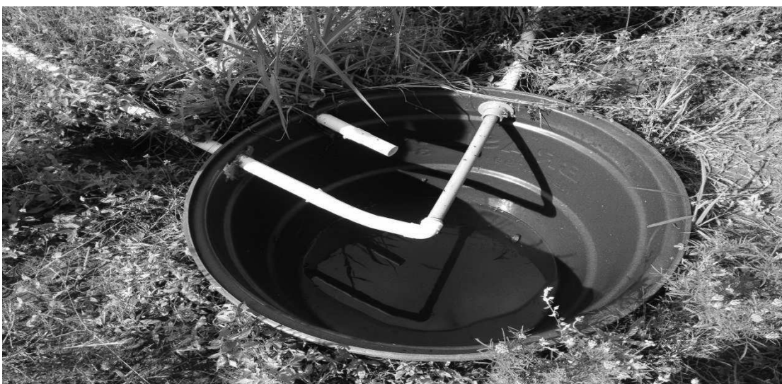
Figura 9: Canalização das águas para dentro da caixa de PVC de 310 litros Fonte: Arquivo pessoal, 2017
