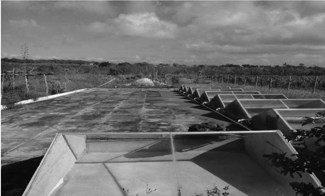
Figura 6: Conjunto de dez dessalinizadores solar construídos sobre a cisterna calçada. Fonte: Arquivo Pessoal, 2017
