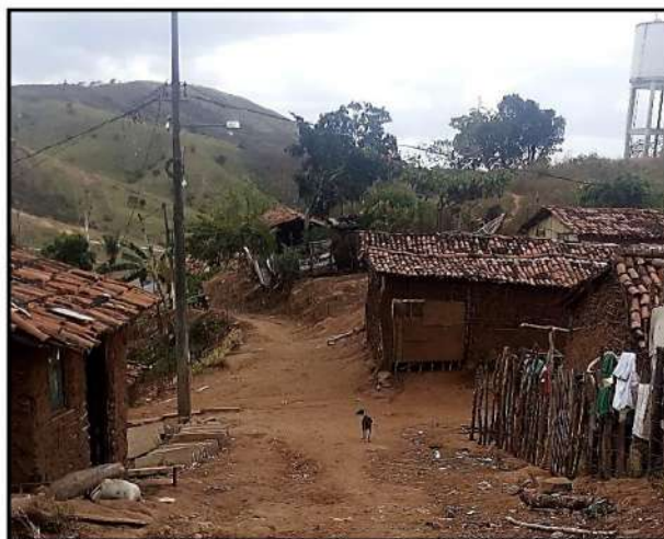
Figura 14- Ausência de pavimento no Alto do Cruzeiro
