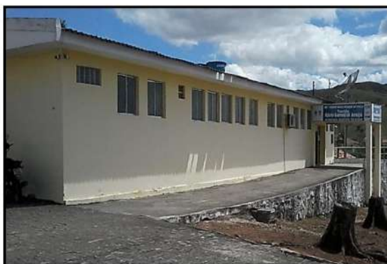
Figura 16- Posto de Saúde que atende as necessidades do povo da comunidade
