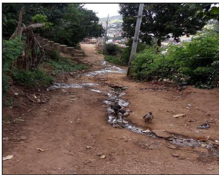
Figura 11-Esgoto a céu aberto no Alto do Cruzeiro
