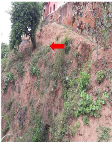
Figura 7- Aspecto da vegetação inclinada.
