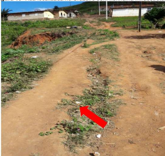
Figura 10- Rua localizada no Cruzeiro sem nenhuma infraestrutura
