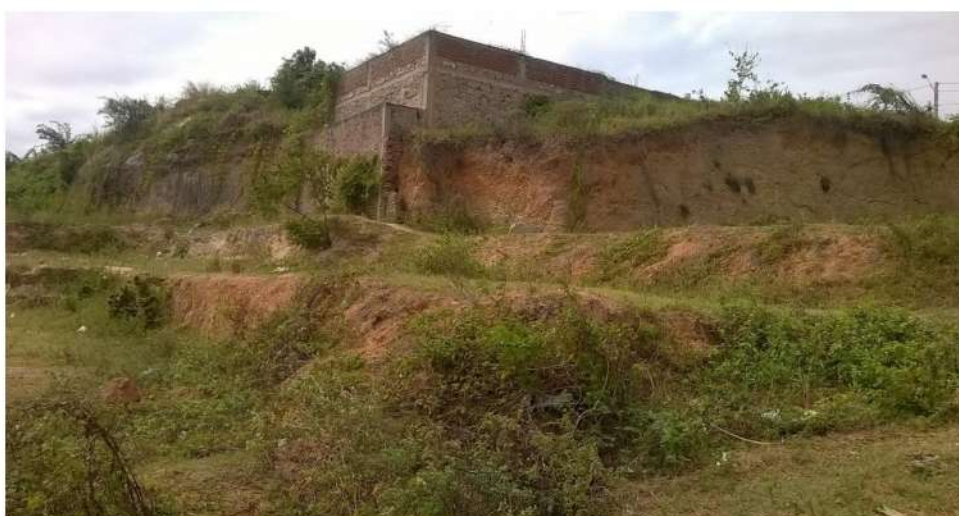
Figura 18: Construção de casas na encosta, Zona Urbana de Serra de São Bento.
