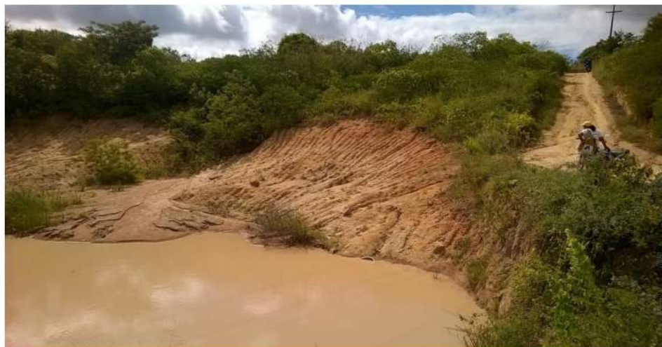
Figura 13: Formação de sulcos em um açude, Sítio Olho D'água Serra de São Bento.
