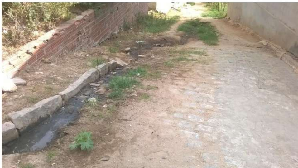
Figura 17: escoamento superficial oriundo do lançamento de esgoto, Zona Urbana de Serra de São Bento.
