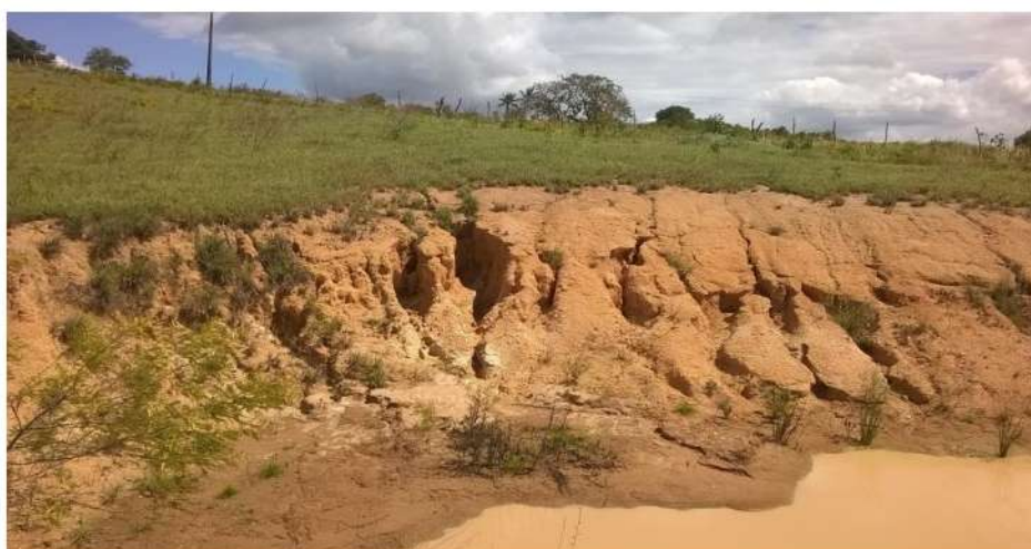
Figura 14: Ravinamento provocado pela entrada de água nas encostas de um açude, Serra de São Bento.
