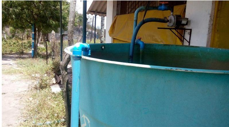
Figura 5: Água do açude saindo da caixa d'água e entrando no filtro.
