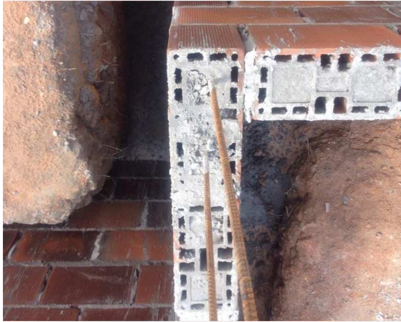
Figura 33: Grauteamento das armaduras.
