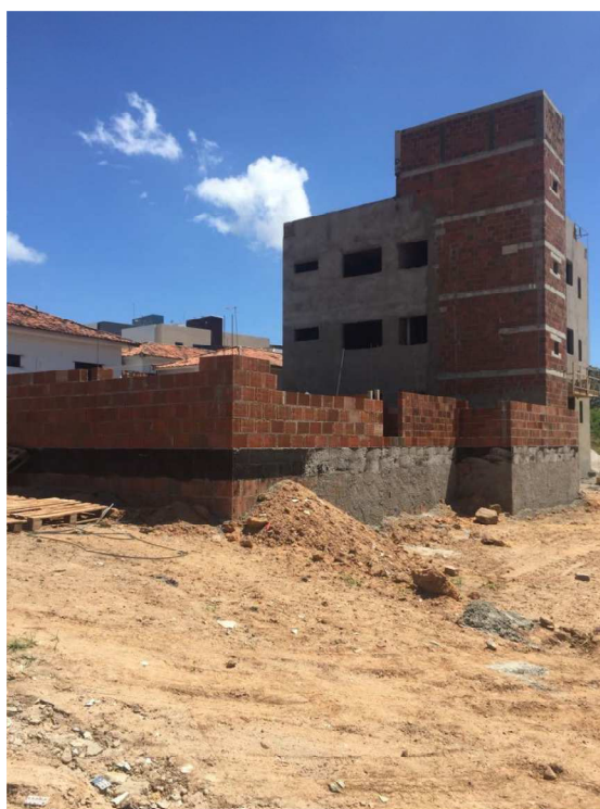
Figura 29: Estado atual da obra.
