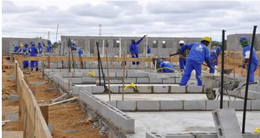
Figura 18: Assentamento da primeira fiada.
