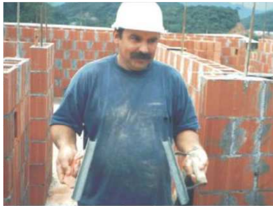
Figura 11: Canaletas de argamassar.
