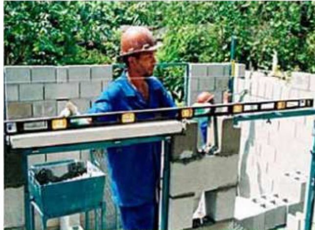
Figura 7: Régua de prumo e nível.
