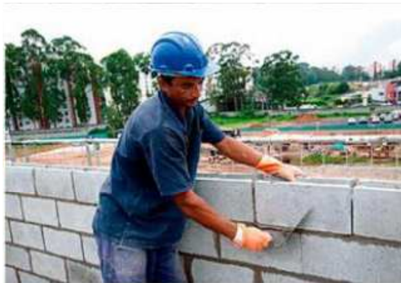
Figura 19: Elevação das Fiadas.
