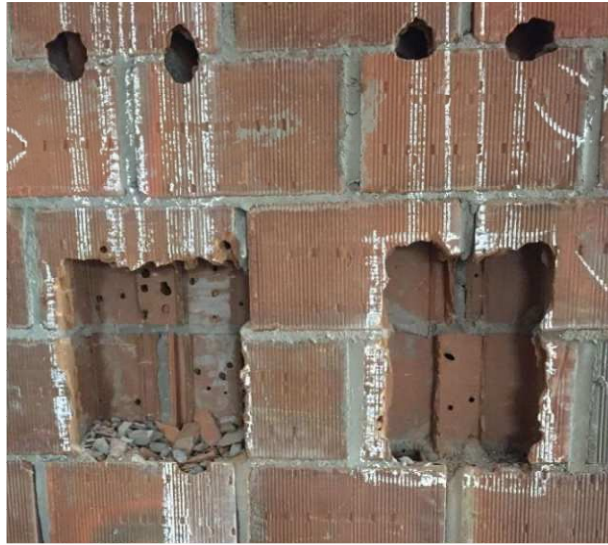
Figura 40: Rasgo na alvenaria para instalações elétricas.
