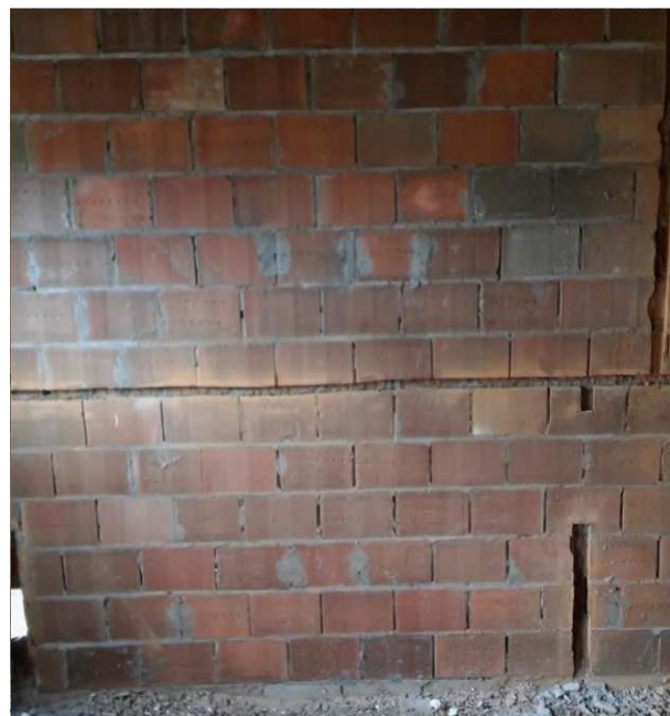
Figura 41: Rasgo na alvenaria para instalações hidráulicas.
