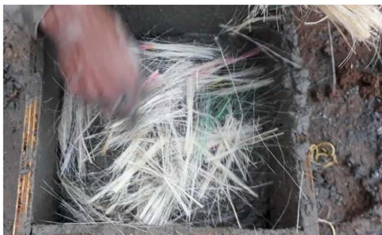
Figura 05: Adição do Agave Sisalana ao concreto
