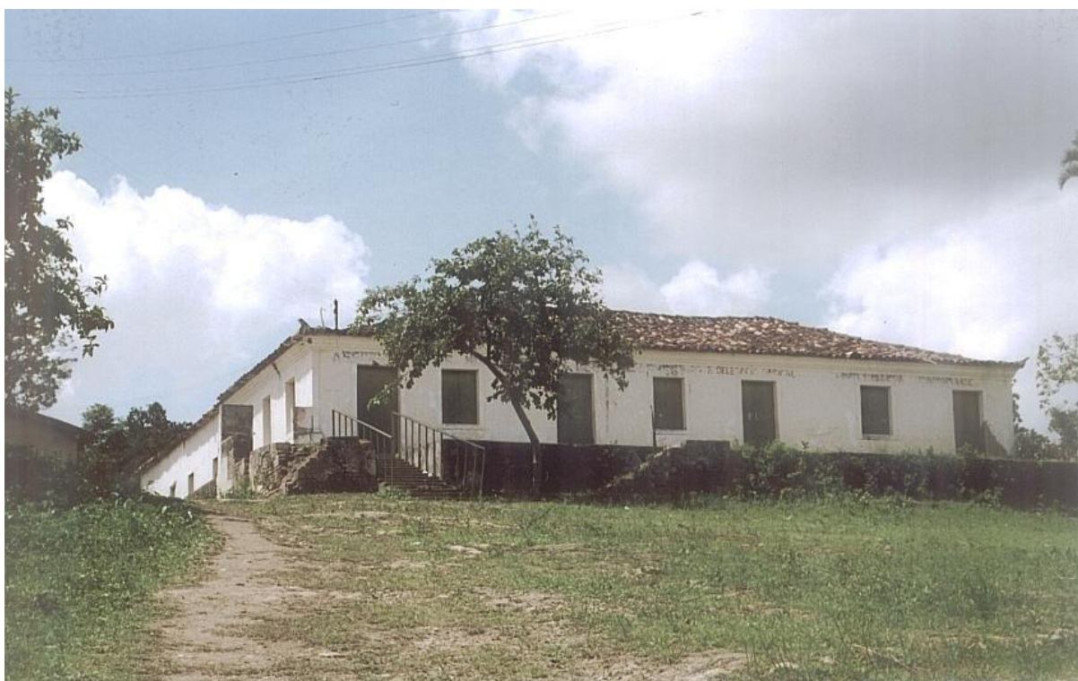
FOTO 18: Casa Grande do Engenho Geraldo, existe desde 1700 Fonte: Joseilton Belarmino (2004)
