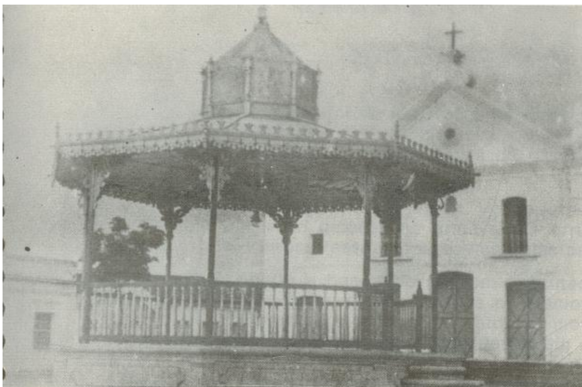
Alagôa-Nova - Coreto construído nos últimos anos da década de 1910. Dr. Laudine era o Juiz Municipal. Ao fundo a fachada da antiga Matriz, demolida no início de 1940.
