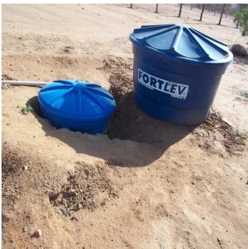
Figura 13. Caixa de armazenamento de água Fonte: Arquivo pessoal
