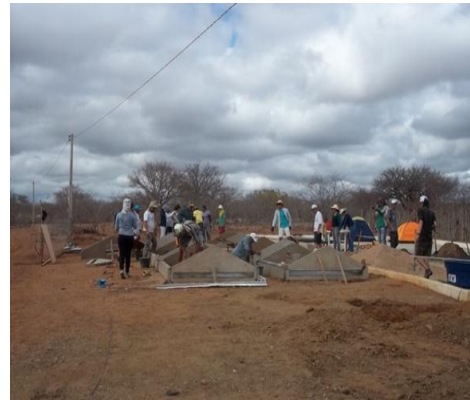
Figura 6. Mutirão na construção Fonte: Arquivo pessoal
