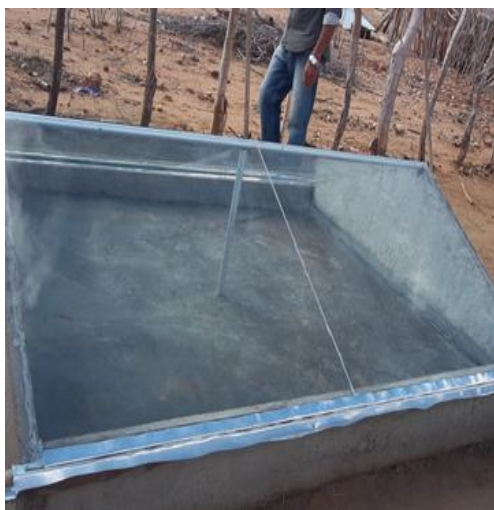
Figura 16. Vidros posicionados nos destiladores Fonte: Arquivo pessoal
