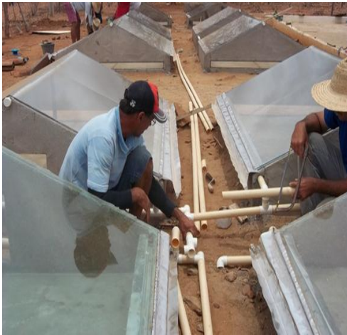
Figura 11. Encanações das canaletas feitas pelos agricultores Fonte: Arquivo pessoal
