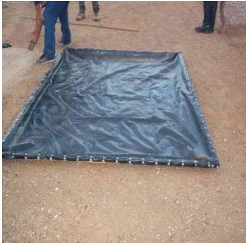
Figura 12. Cisternas onde coloca a água do poço. Fonte: Arquivo pessoal
