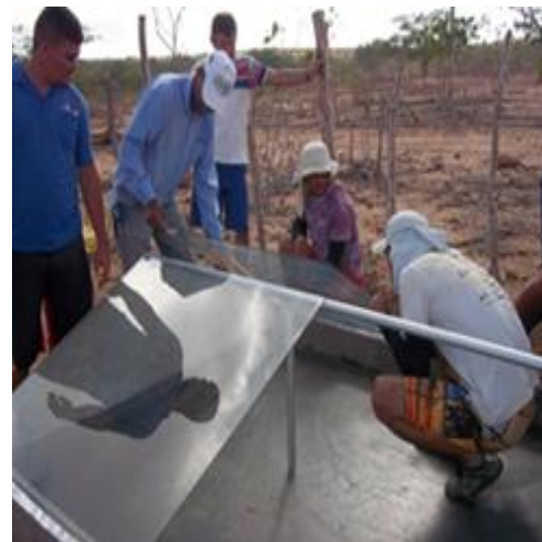
Figura 15. Colocando os vidros Fonte: Arquivo pessoal
