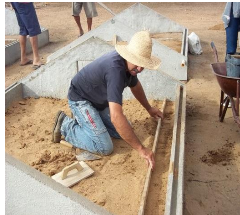
Figura 8. Agricultor RB nivelando parte de areia Fonte: Arquivo pessoal
