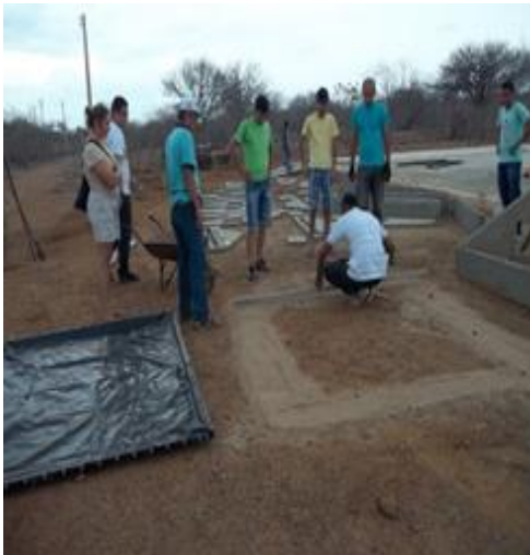
Figura 14. Equipe nivelando o local Fonte: Arquivo pessoal
