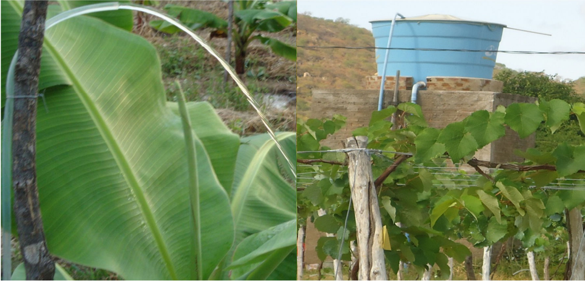
Figura 5. Sistema de irrigação “Bubler” e caixa de distribuição, utilizando-se energia gravitacional, Estação Experimental Agroecológica, Campus IV da UEPB, Catolé do Rocha-PB.
