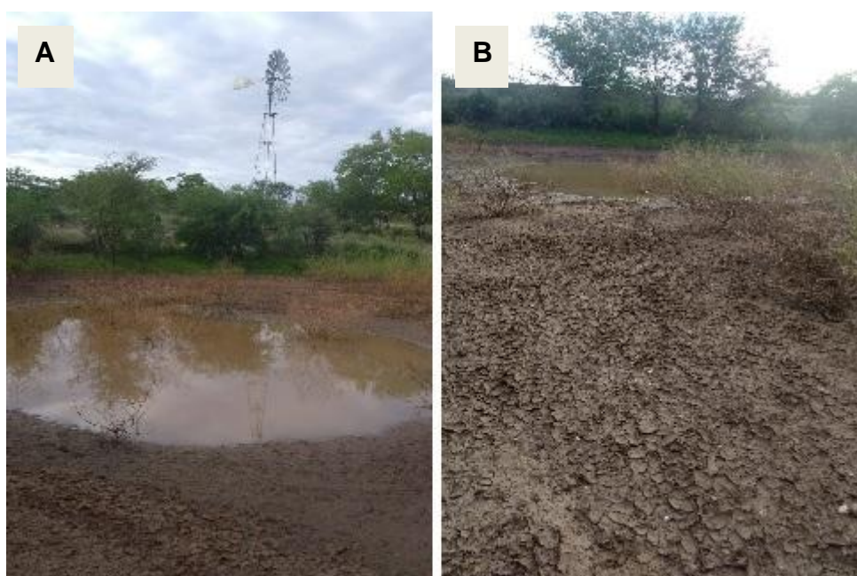
Figura 4 – Barreiro de reservatório de água do Sitio Aroeiras em Serra Branca-PB, construído em um riacho geralmente com força braçal, para armazenagem de água da chuva – 2019.
