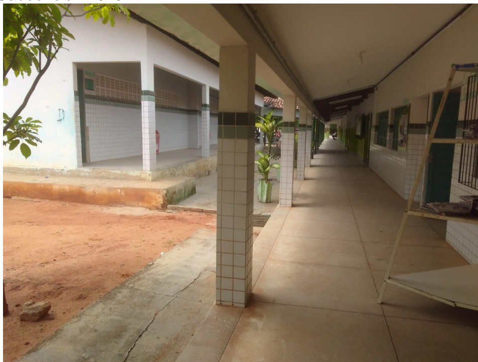
Figura 8 – Corredor de salas de aula da Escola Estadual Senador José Gaudêncio - 2019.
