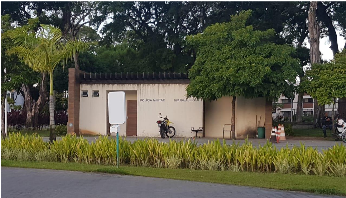
Foto 06: Posto de polícia militar construído após a última intervenção
