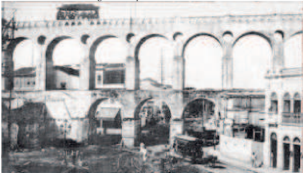
Figura 4 – Aqueduto do Rio Carioca.
