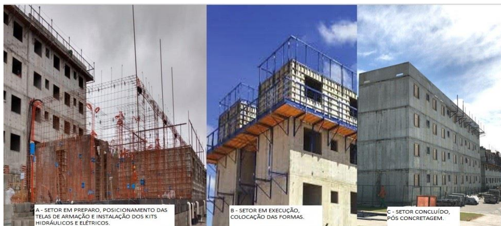
Figura 1. Etapas sequencias do sistema construtivo de parede de concreto
