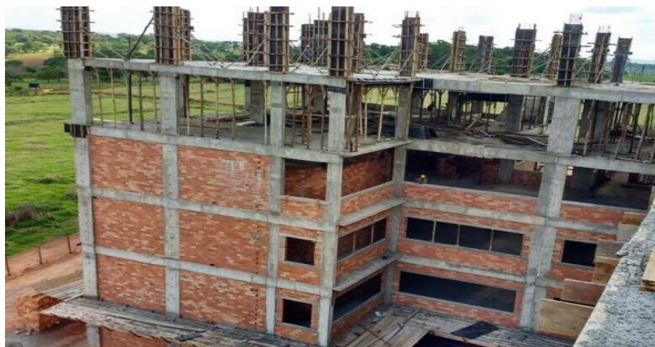
Figura 2. Sistema construtivo de alvenaria convencional
