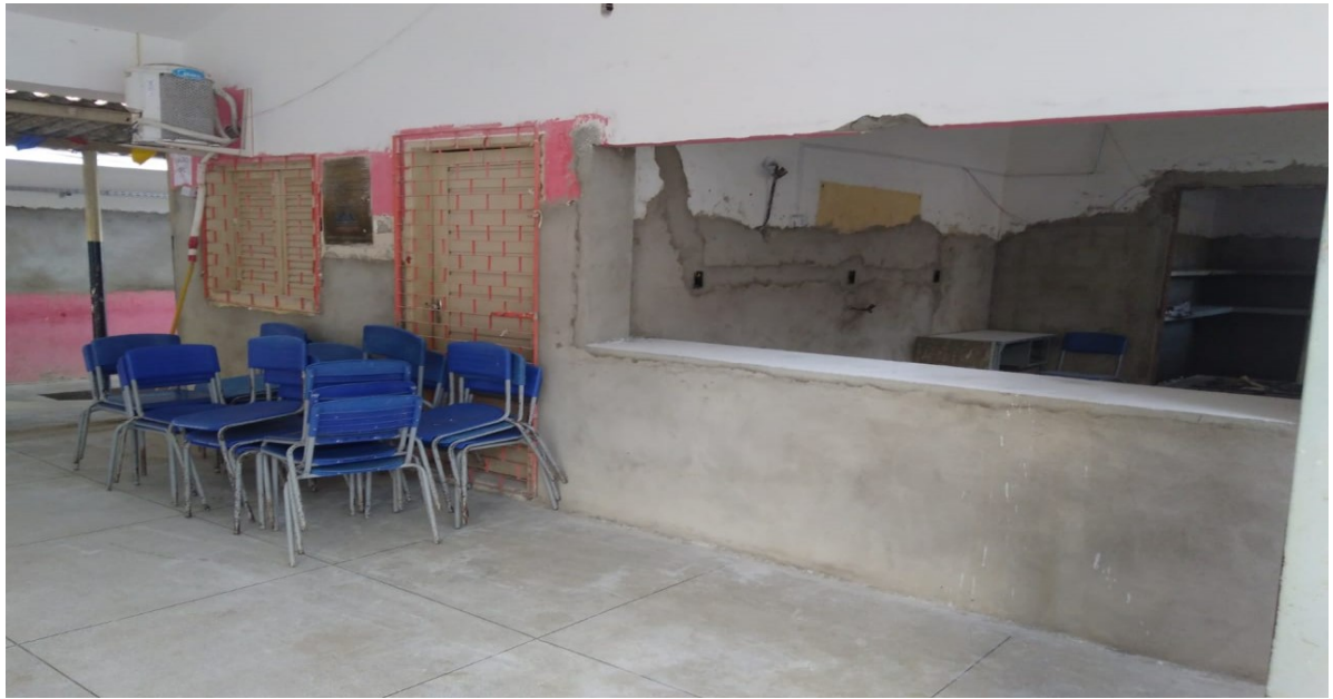
Figura 4: A cantina da Escola sendo reformada.
