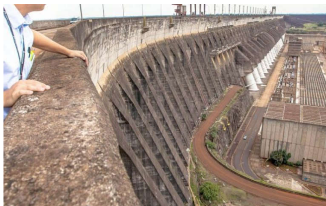
Figura 9 - Barragem de concreto em contraforte
