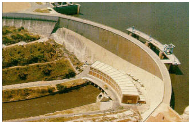
Figura 11 - Barragem abóbada (em arco)
