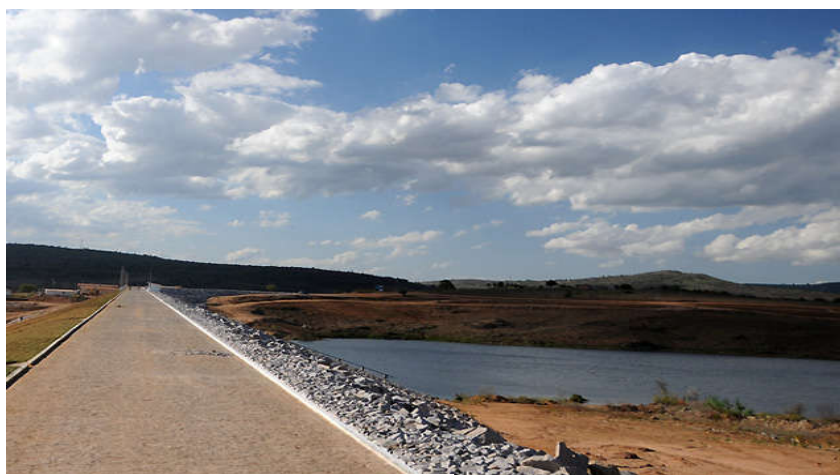
Figura 6 - Barragem de terra-enrocamento
