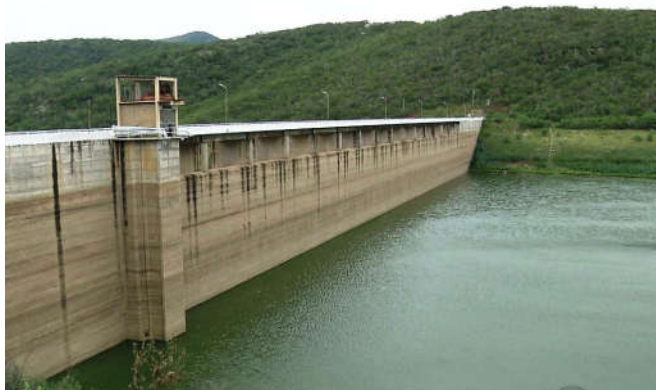
Figura 10 - Barragem de Concreto Compactado a Rolo (CCR)
