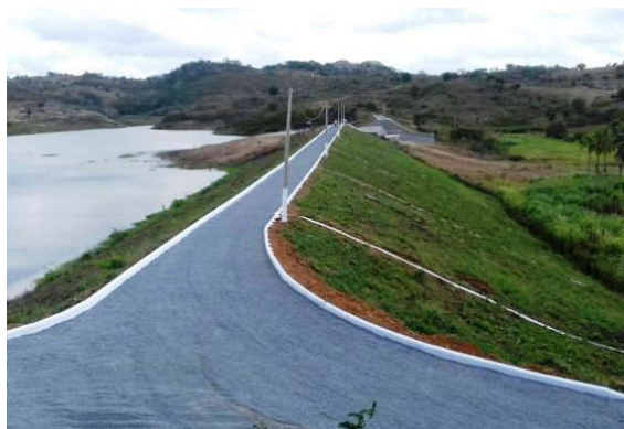
Figura 5 - Barragem de terra homogênea
