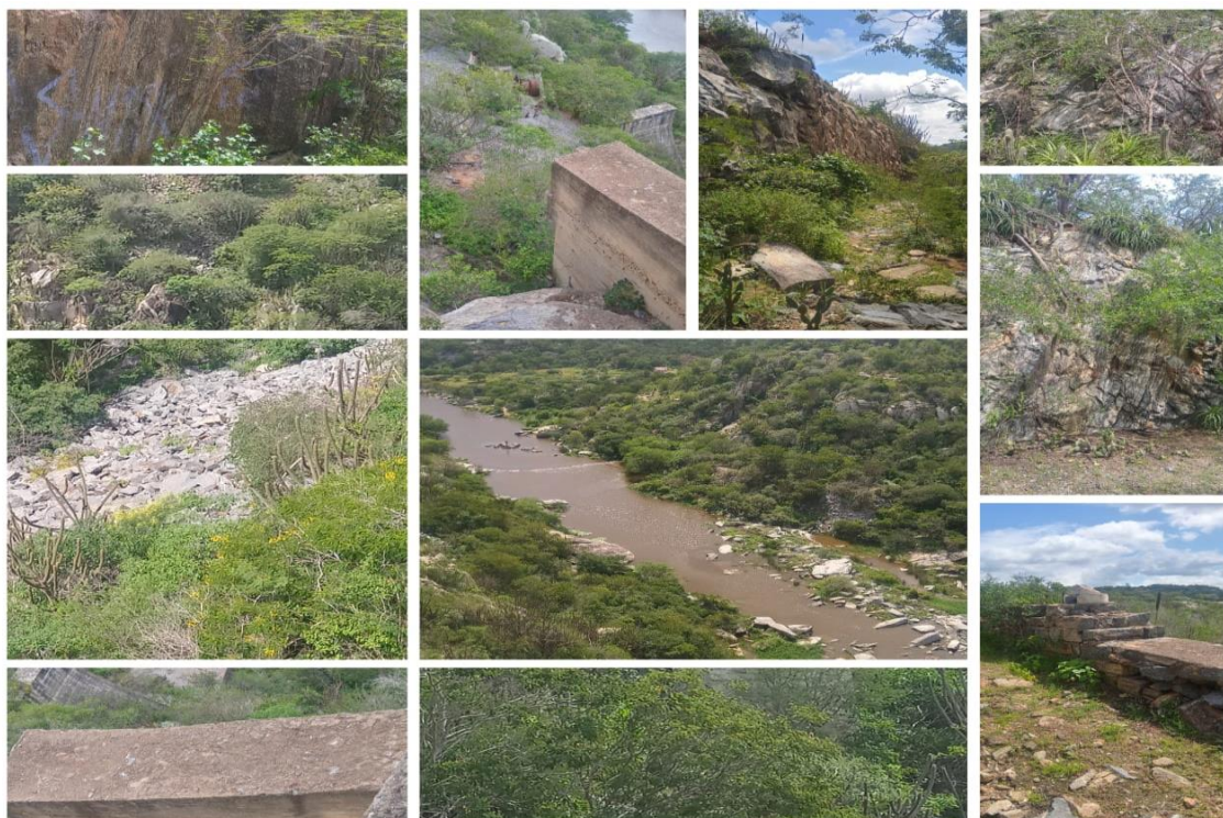
Figura 12 - Estruturas da Barragem ( Atualmente)
