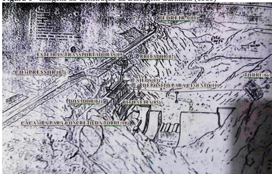
Figura 6 - Imagens da Construção da Barragem Curimatã (1959)
