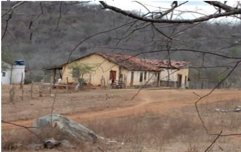
Figura 3 - Primeira casa construída (fundos)
